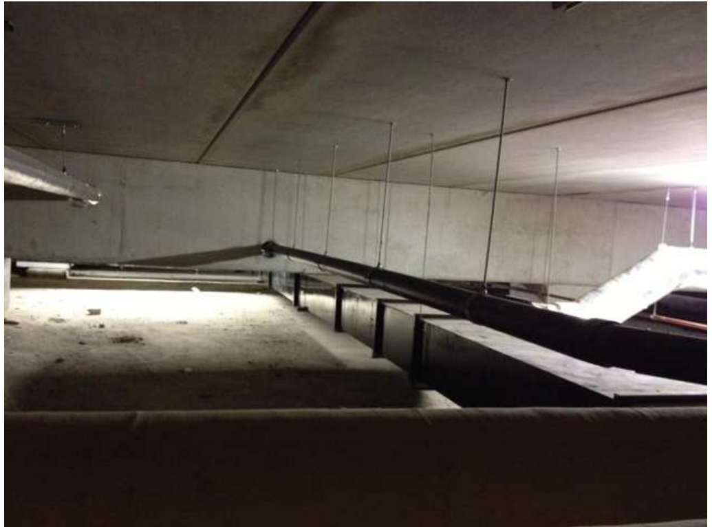
Foto 1: Kelder ter plaatse van het voormalige postkantoor
